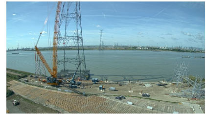
Montage der Gittermasten an der Schelde in Antwerpen
