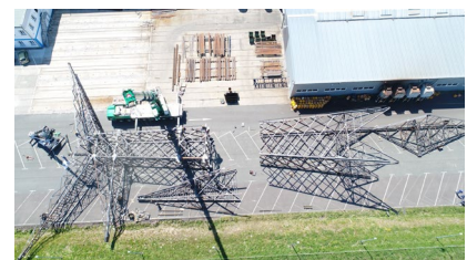
Probemontage des oberen Teiles des 192-m-Gittermastes
