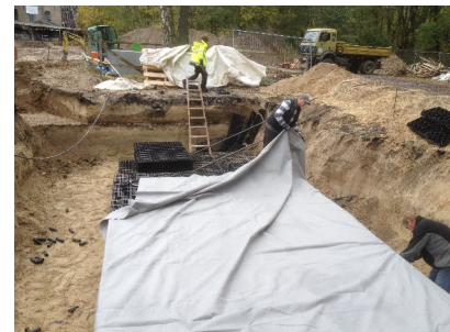
Einbau der Rigole zur Versickerung des Niederschlagswassers
