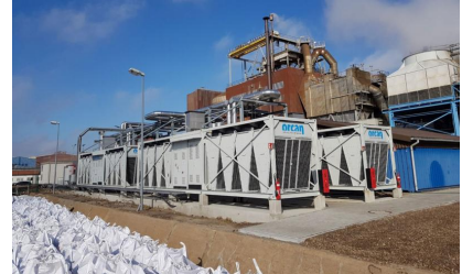
Vier Orcan Energy Module des Typs ePI 150.200 sorgen bei der Nordenhamer Zinkhütte GmbH für nachhaltige Abwärmennutzung
