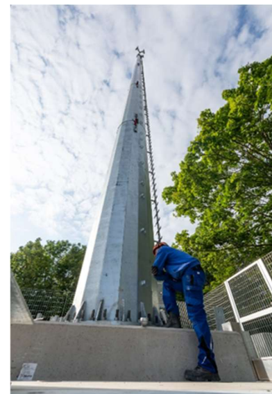
Dauerhafter Korrosionsschutz des Funkturms durch wartungsarme Feuerverzinkung
