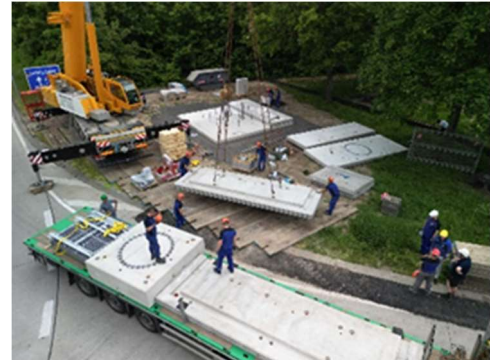
Vorgefertigtes „Fast Site“-Fundament
