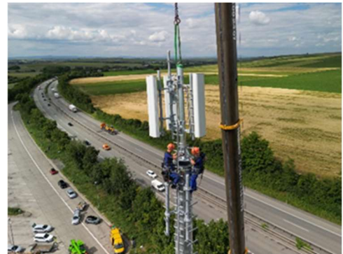
Endmontage der Telekommunikationseinheit auf dem „Fast Site“-Funkturn
