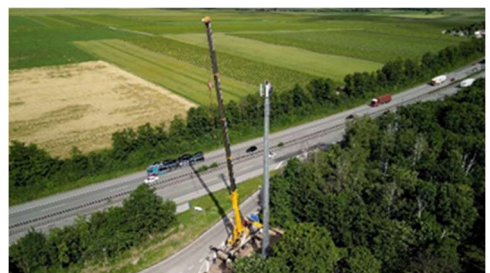
„Fast Site“-Funkturn, Fertigstellung an einem Tag – geringste Verkehrsbeeinträchtigung
