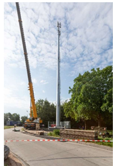
WIEGEL-Tochter TKS errichtet erstmals modularen Funkturm vom Typ „Fast Site“
